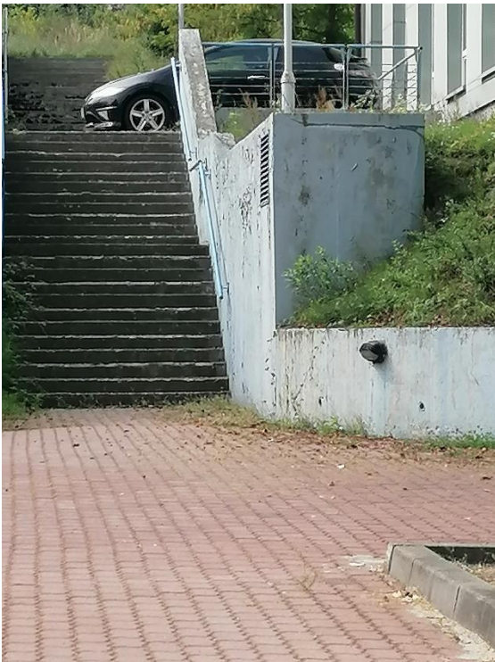
schody i murek oporowy:
